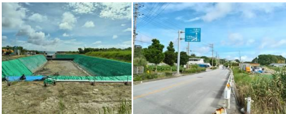
具志川地区排水路整備工事
